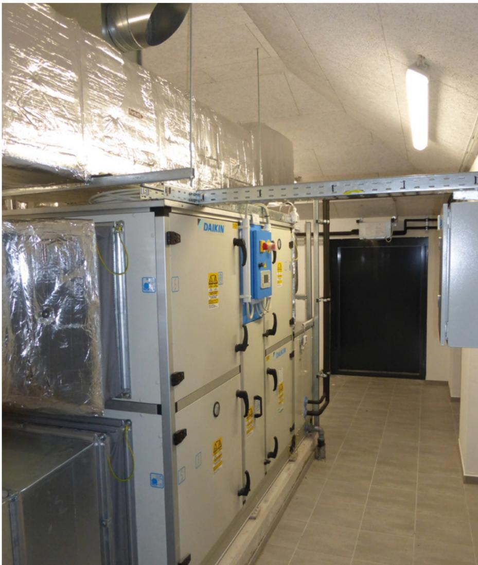
Das Lüftungsgerät der Serie Modular P ist für ein Luftstromvolumen von 3.000 m<sup>3</sup>/h ausgelegt.
