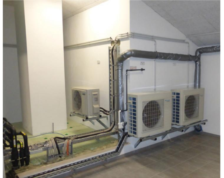
Auch die Außengeräte der Klimageräte für Server- und Technikraum sind im Dachgeschoss montiert.
