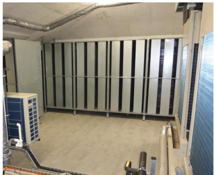
Vor den Fenstergittern im Dachgeschoss hat die Firma KKE Schalldämpfer angebracht.
