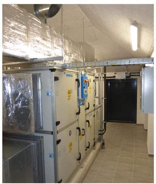
Das Lüftungsgerät der Serie Modular P ist für ein Luftstromvolumen von 3.000  $\mathrm{m^3/}$  h ausgelegt.
