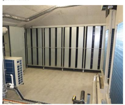
$Vor den \, Fenstergittern \, im \, Dachgeschoss \, hat \, die \, Firma \, KKE \, Schalld\"{a}mpfer \, angebracht.$
