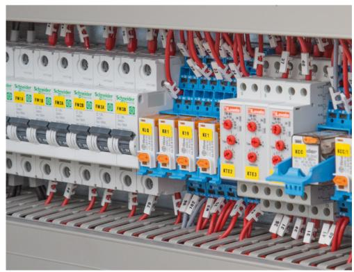
Logischer, geordneter und "aufgeräumter" Aufbau im Schaltschrank.
