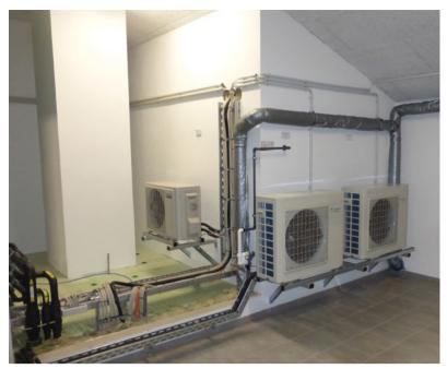
Auch die Außengeräte der Klimageräte für Server- und Technikraum sind im Dachgeschoss montiert.
